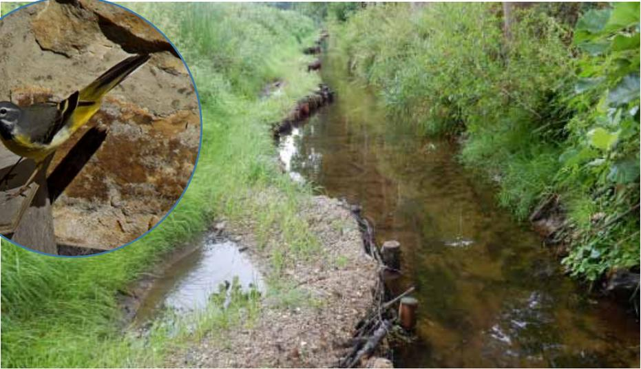
Häufig sind bestehende Profile im Niedrig- und Mittelwasserbereich zu groß dimensioniert. Anzustreben ist eine Breite, die einen „Bett bildenden Abfluß“ ermöglicht.
