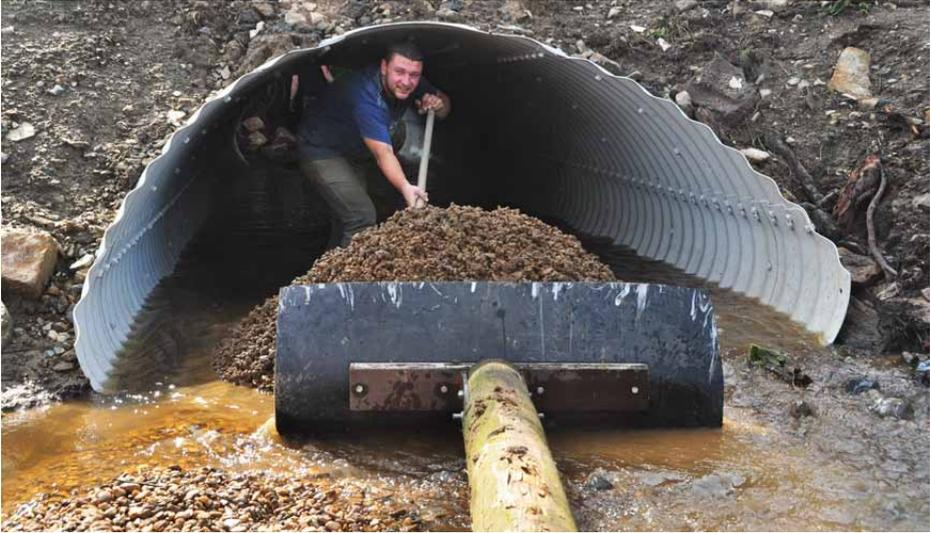
Damit Durchlässe passierbar sind, muss das Sohlsubstrat in einer angemessenen Auflage eingebaut werden. Häufig wird das Substrat transportiert und mitunter restlos fortgespült.
