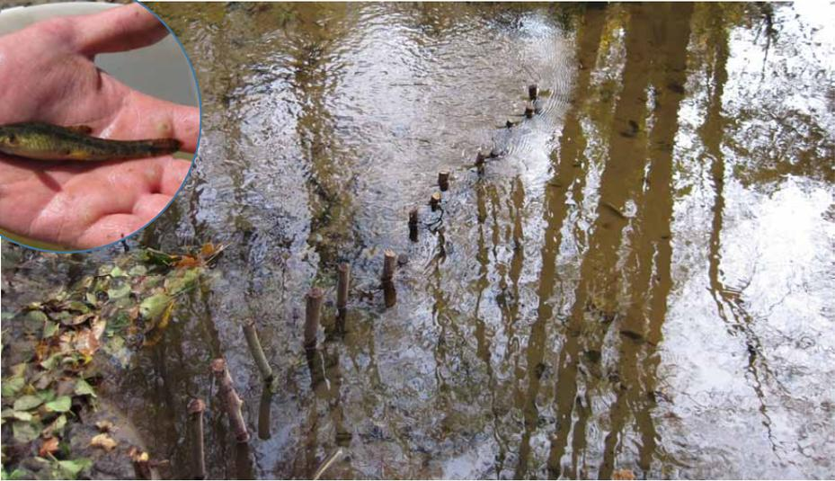
Gut ins Ufer eingebunden werden spazierstockdünne Ast-Pfähle bis zur Mittelwasserlinie in den Gewässergrund gerammt. Die Zwischenräume im Uferbereich enger und zur Gewässermittle hin auf 10-15 cm setzen. Treibendes Material und Geschiebe gestalten die weitere Entwicklung. Der vorher durch übermäßigen hydraulischen Druck bei fehlenden Baumwurzeln erodierte Gleithang kann wieder entstehen (nach MADSEN und TENT 2000).
