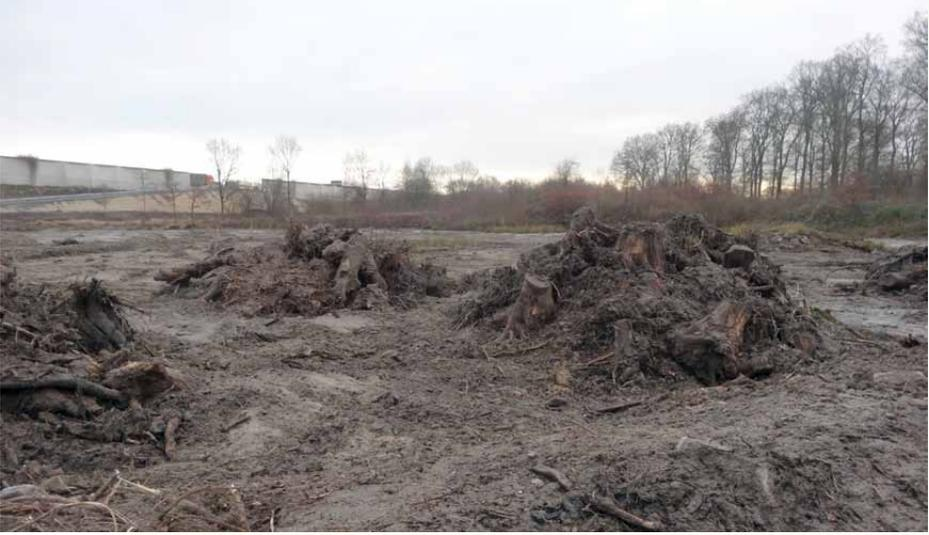
Stümpfe und Wurzelteller, die durch den Abtrag des Bodens angefallen sind, können vermischt mit Sand am oberen Rand der neuen Aue platziert werden. Auch übrig gebliebene Steine und Äste können dafür verwendet werden.
