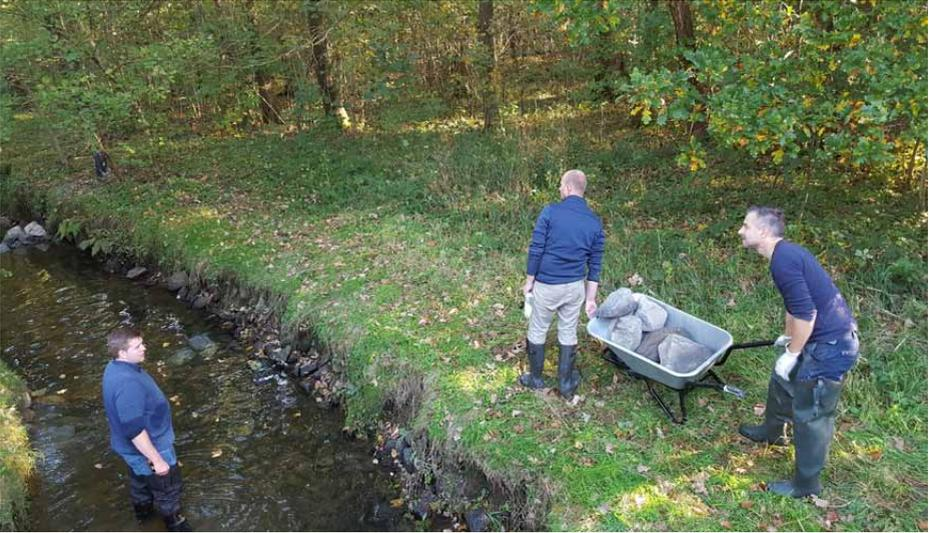
Egal ob aus Holz oder Stein - Länge, Winkel, Einbauhöhe und die Bedingungen vor Ort wirken sich auf die Funktion aus. **Beim Einbau** werden die zu erwartenden Auswirkungen durch eingestreute Holzspäne sichtbar gemacht. Dadurch lässt sich die optimale Ausrichtung ermitteln. Dies ist besonders wichtig, wenn keine ausreichend breiten Gewässerrandstreifen zur Verfügung stehen. Eine zusätzliche Sicherung des angeströmten Ufers ist sinnvoll z.B. durch parallelverbaute Tothölzer.
